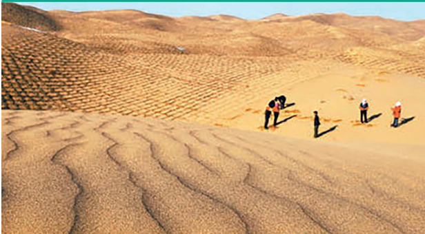
图 9: 利用草方格固沙(左)和飞播造林(右)控制荒漠化
